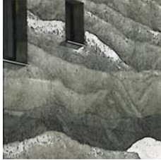
Giardin Dwellings, Samedan, CH, 2007 Mierta & Kurt Lazzarini Architekten
