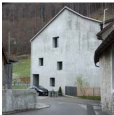
Haus Meuli, Fläsch, CH, 2001 Bearth & Deplazes
